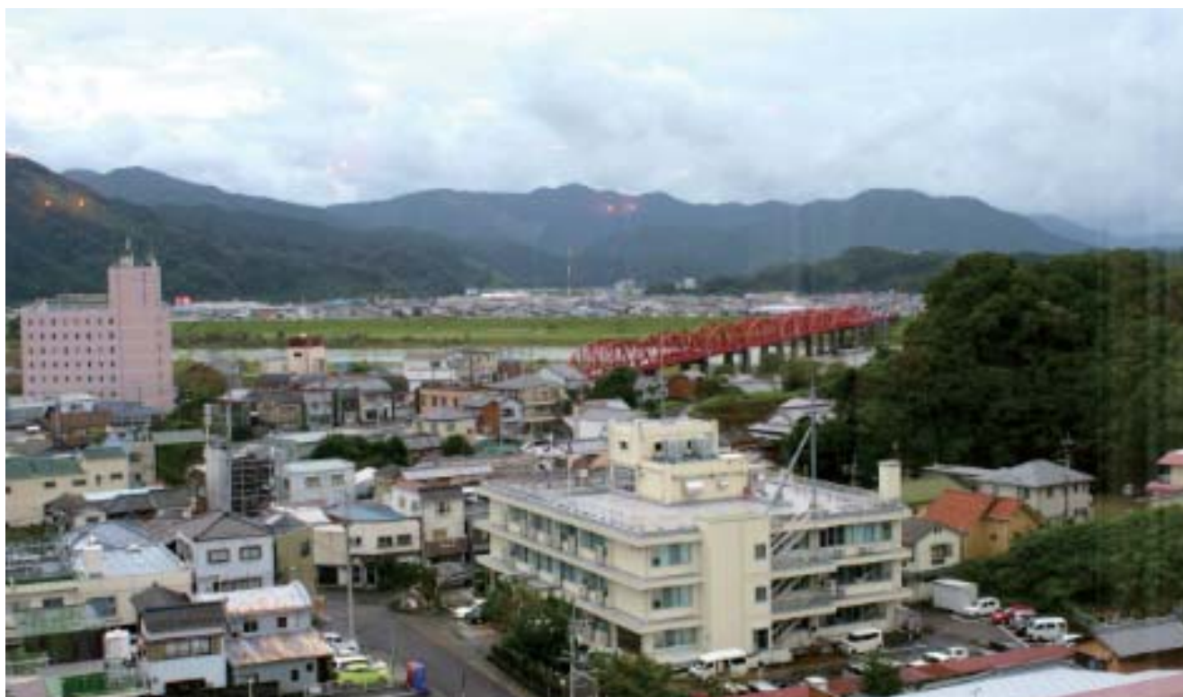
ホテル10階より見下ろす、四万十川美化ゾーン
